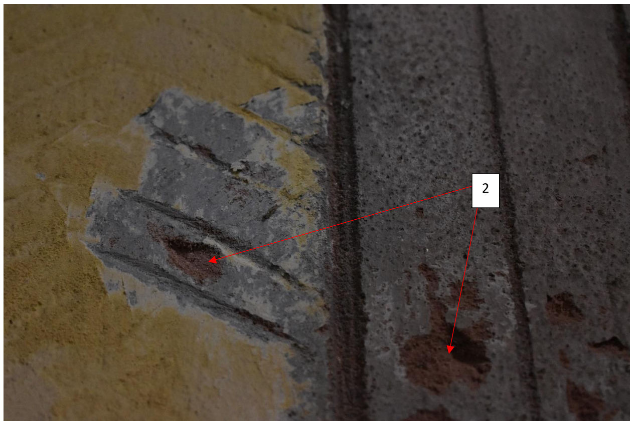
Odkrywka nr 8 - ściana wschodnia, prezbiterium, prawy pas dekoracji, wys. ok. 2,5 m
