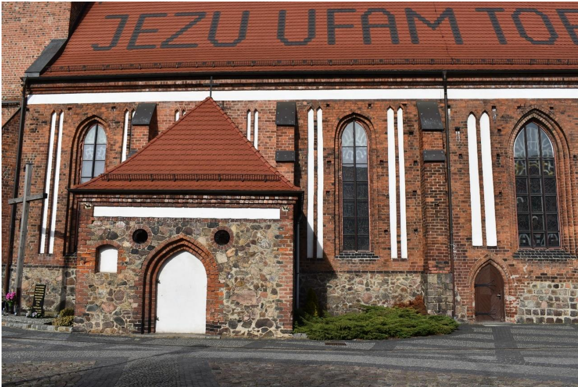
Fot.4. Elewacja południowa – detal.
