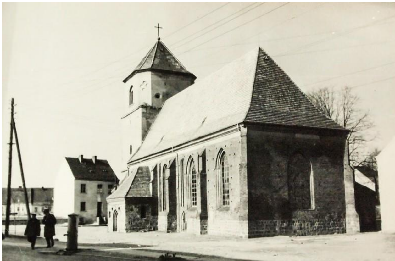
Il. 46. 1961 – Widoczne jeszcze zachowane tynki na wieży. ( Sulęcín -stare zdjęcia i Fotografie, facebook.pl )
