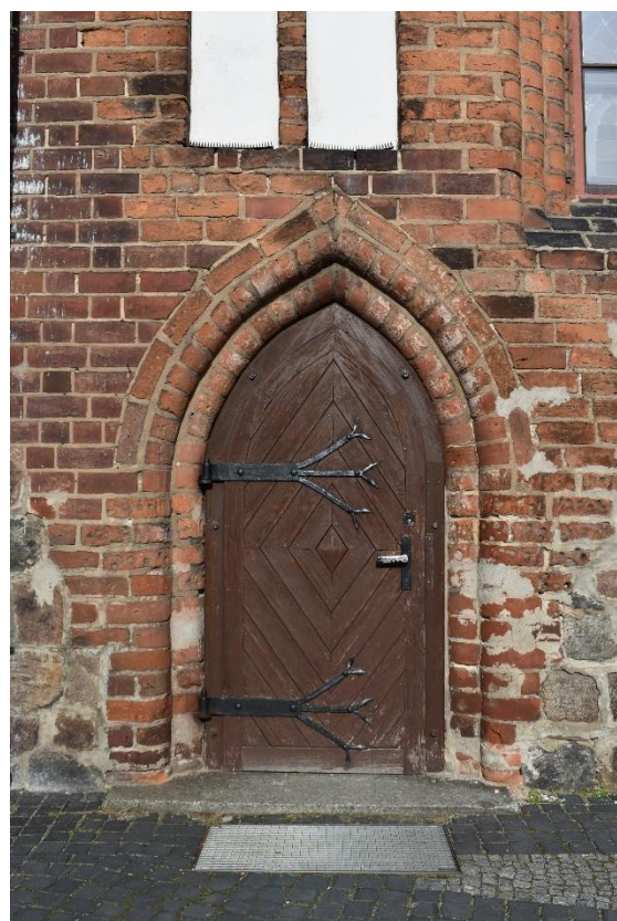
Fot. 7. Elewacja południowa -portal.
