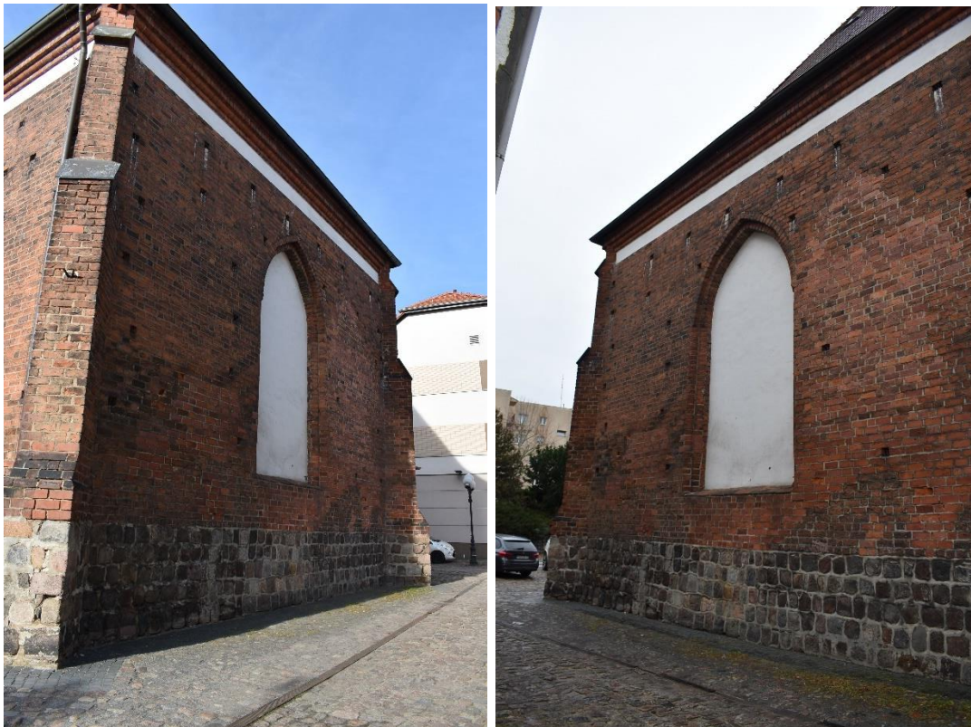
Fot.9, 10. Elewacja wschodnia.
