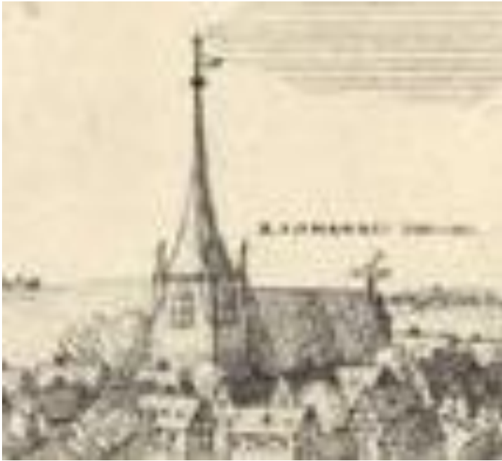
Wieża z hełmem w formie XV-wiecznej. (Widoczna jeszcze na rycinie z ok.1710 r.)
