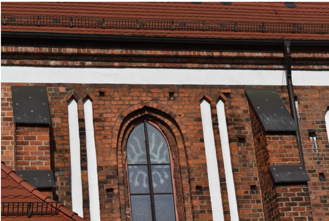
Fot.5. Elewacja południowa -detal.
