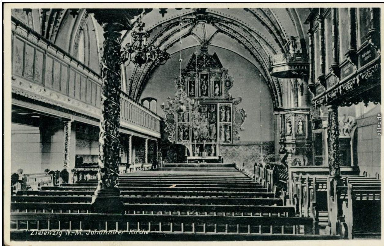
Il.19. Wnętrze kościoła przed 1945r. (Sulęcín -stare zdjęcia i Fotografie, facebook.pl)
