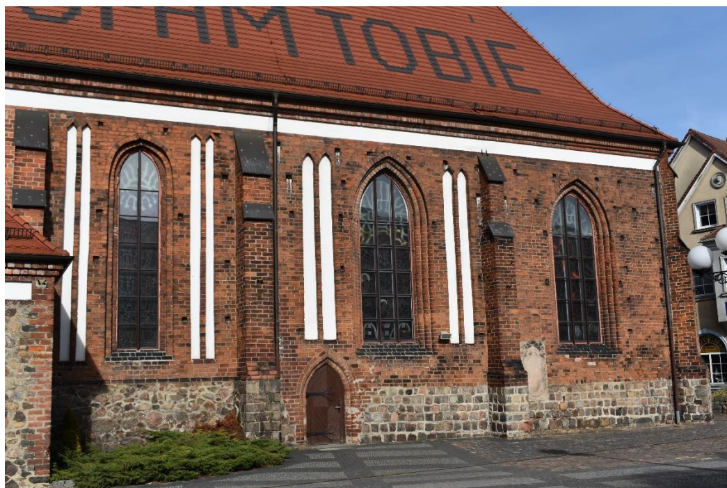
Fot.6. Elewacja południowa -detal.
