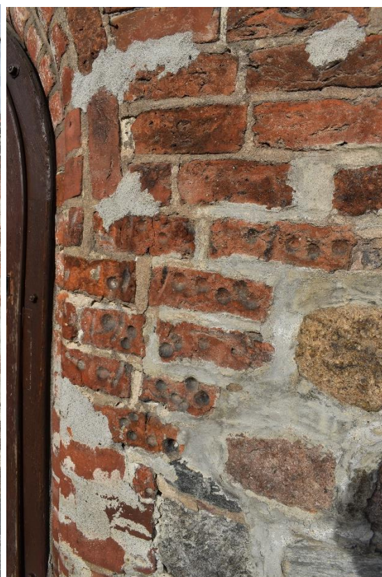
Fot.8.Ślady świdrów ogniowych przy portalu.
